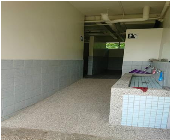
一樓廁所入口有坡道設計
